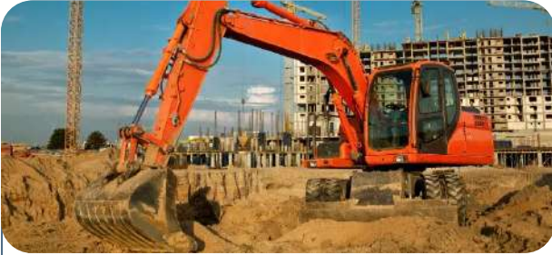
ENGINS DE CHANTIER
