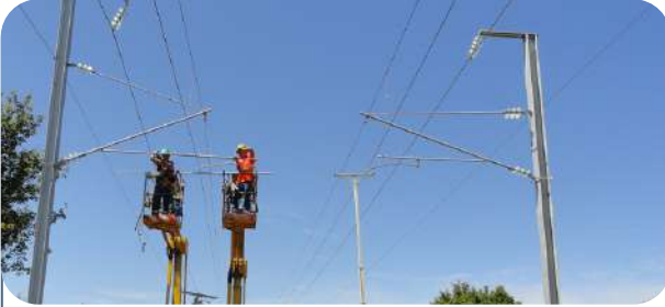
INTERVENTION SUR CATÉNAIRES
