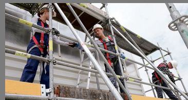
■ Echafaudage fixe et roulant
